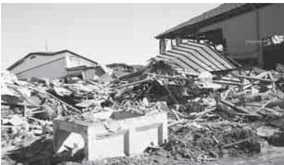
移動中の車窓からは瓦礫の山と化したさまざま光景が続いた
