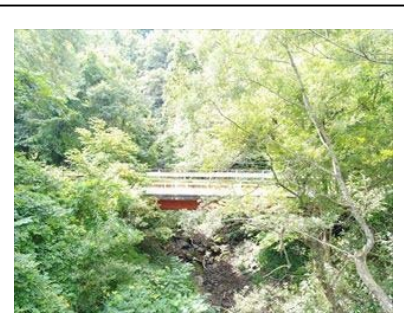
〈移管対象〉佐助沢橋
