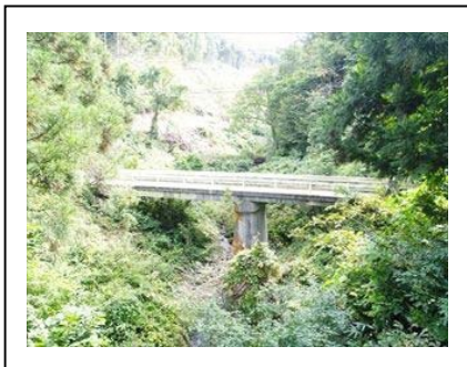
〈移管対象〉関谷橋
