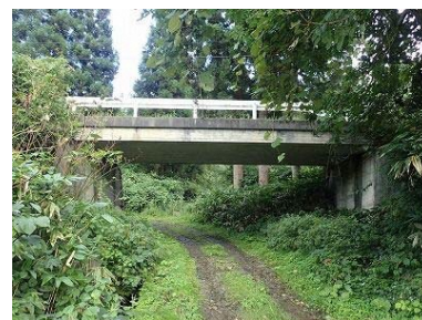
〈移管対象〉水湊橋
