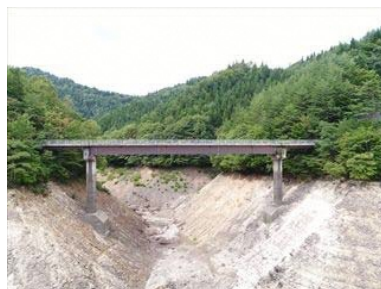
〈移管対象〉尻高沢橋
