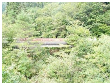
〈移管対象〉大白石橋
