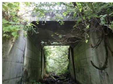
〈移管対象〉岩谷沢橋
