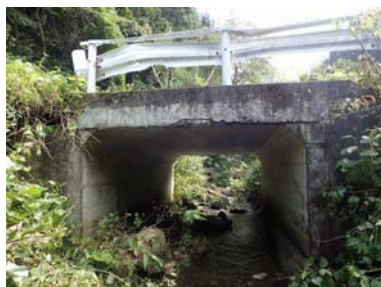
〈移管対象〉大鳥沢橋
