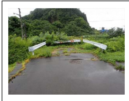
〈撤去対象〉川崎橋
